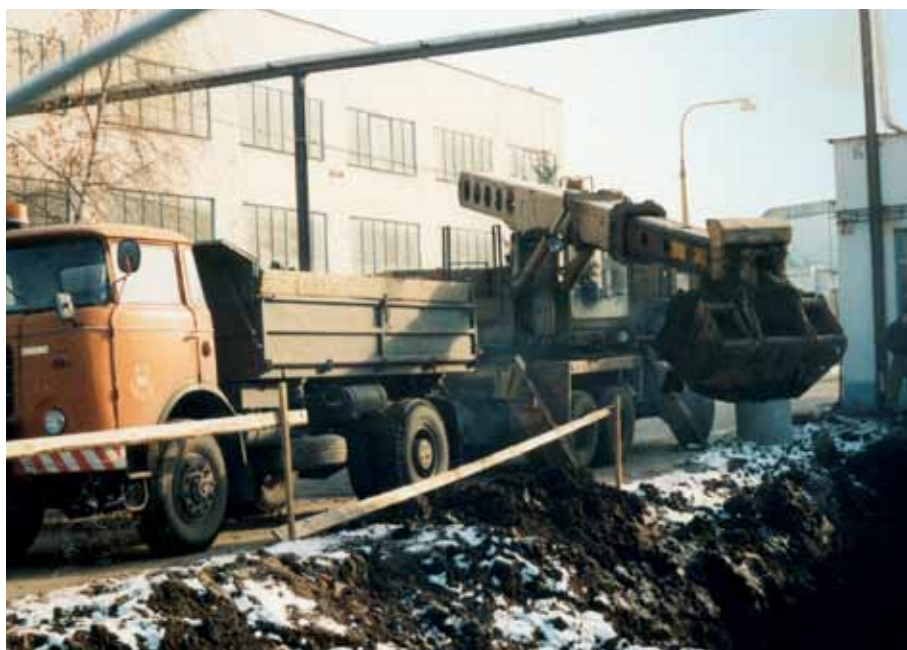
Obr. 5.1.15. Detva – vyťaženie znečistenej zeminý (foto HES-COMGEO, s. r. o.).
