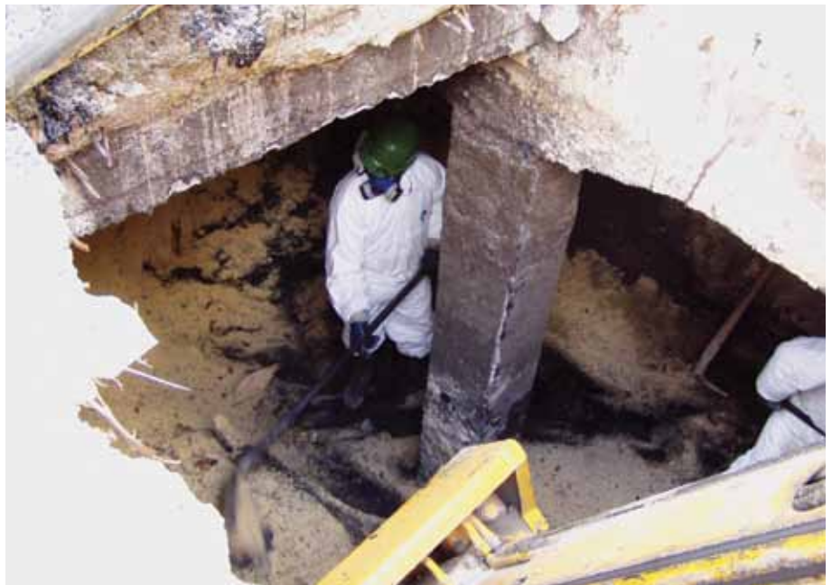
Obr. 5.1.26. Bratislava-Mlynské Nivy, areál SPP, a. s. – dekontaminácia dechtovej vane (archív ENVIRONCENTRUM, spol. s r. o.).
