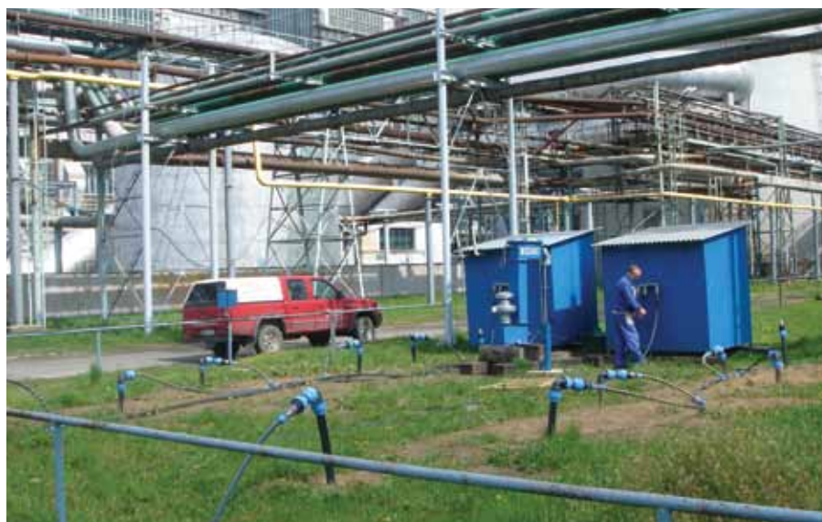
Obr. 5.1.22. Vojany, EVO II – sanačná stanica (foto GEO Slovakia, spol. s r. o.).
