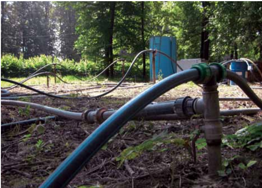
Obr. 5.2.8. Přerov, letisko – aplikačná sonda, v pozadí sanačná stanica (bioreaktor, dúchadlo, nádrž so živinami) (foto EPS, spol. s r. o.).
