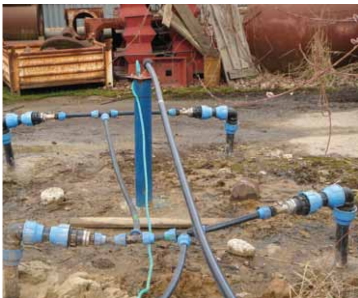
Obr. 5.1.32. Vojany – prevzdušňovací vrt a štvorica odsávacích ventingových vrtov (foto GEO Slovakia, s. r. o.).
