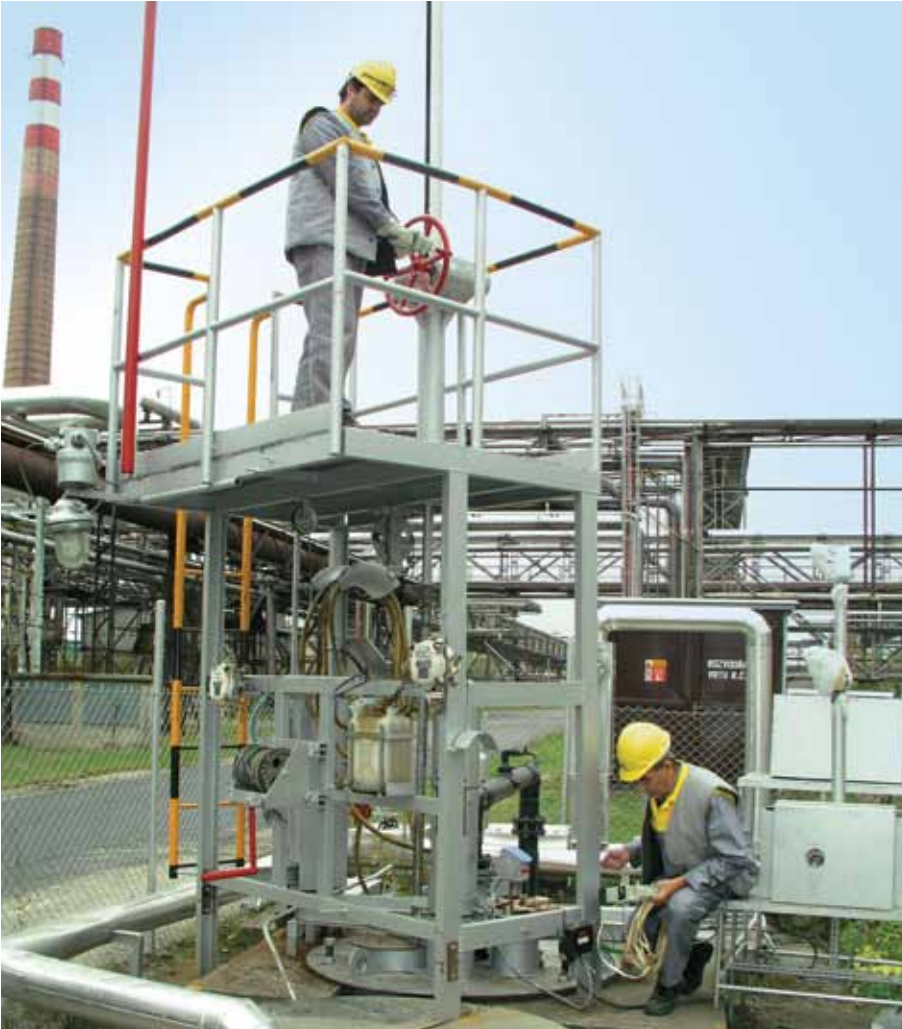
Obr. 5.1.30. Bratislava, areál Slovnaftu, a. s. – nastavovanie zberného valca na ropné látky vo vrte na vnútornej línii hydraulického clony (archív GEOtest Bratislava, s. r. o.).
