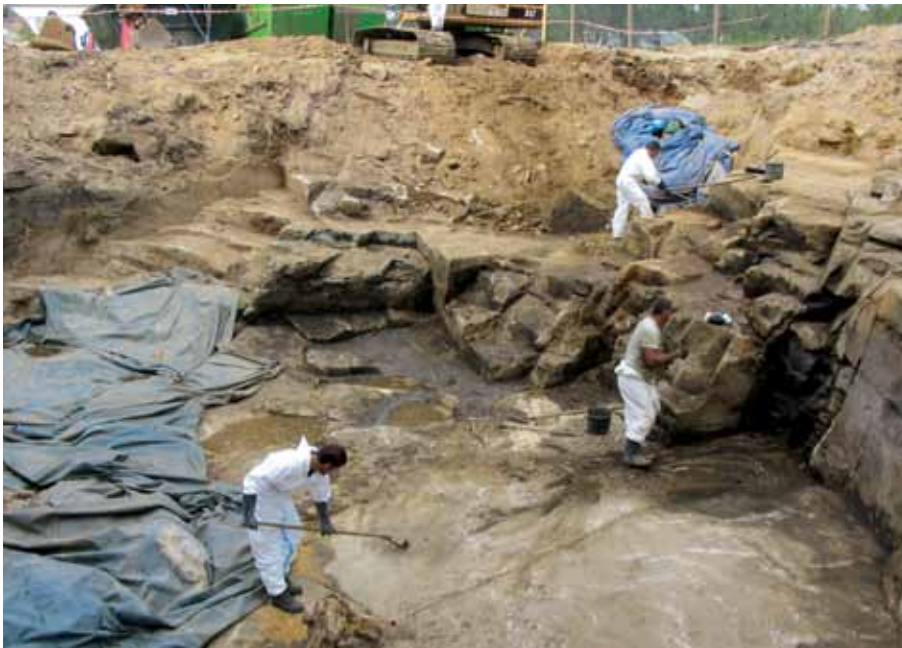
Obr. 5.2.2. Nový Rychnov, skládka priemyselného odpadu – dočistovanie kontaminovanej zeminy po vyťažení, príprava na rekultiváciu (archív DEKONTA, a. s.).
