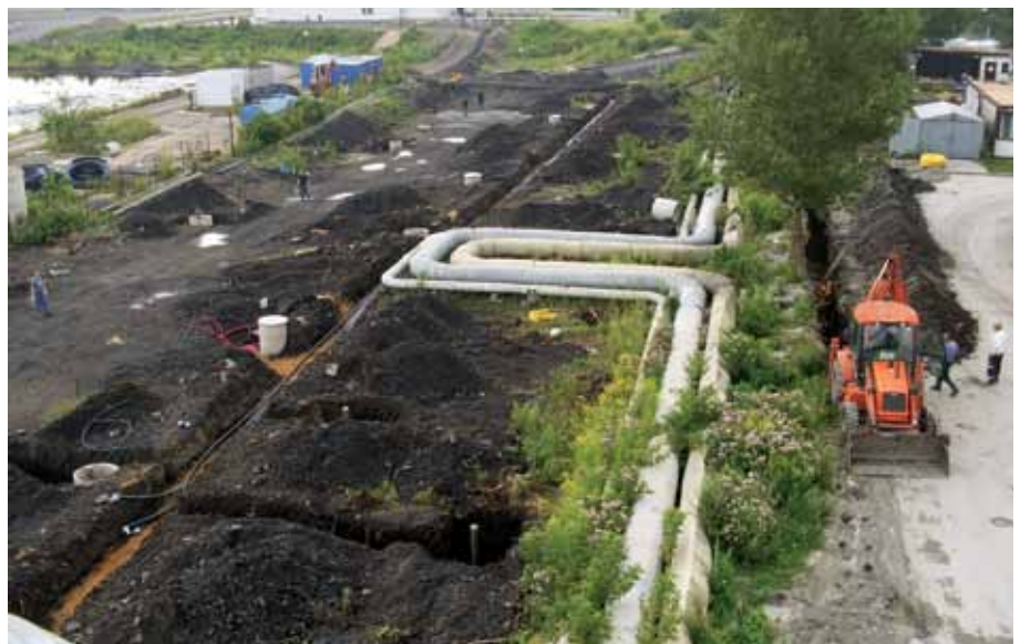
Obr. 5.2.12. Budovanie podzemnej tesniacej steny (foto AQUATEST, a. s.).
