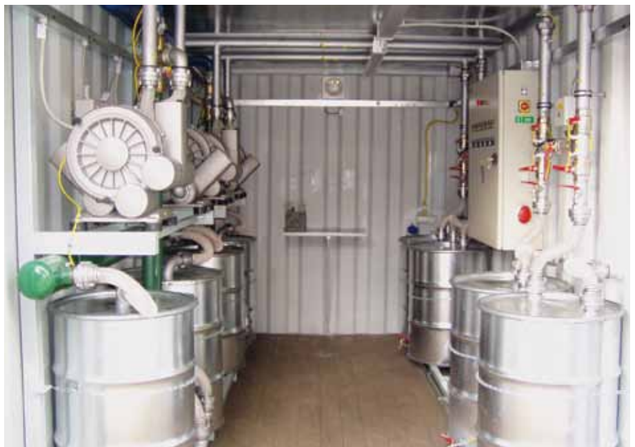
Obr. 5.1.27. Bratislava-Mlynské Nivy, areál SPP, a. s. – sanačná stanica na vákuovú extrakciu a aeráciu (archív ENVIRONCENTRUM, spol. s r. o.).
