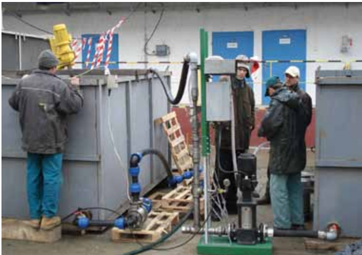
Obr. 5.1.9. Piešťany, areál bývalej Tesly – sanačná jednotka, príprava roztoku KMnO_4 na chemickú oxidáciu (foto ENVIGEO, a. s.).
