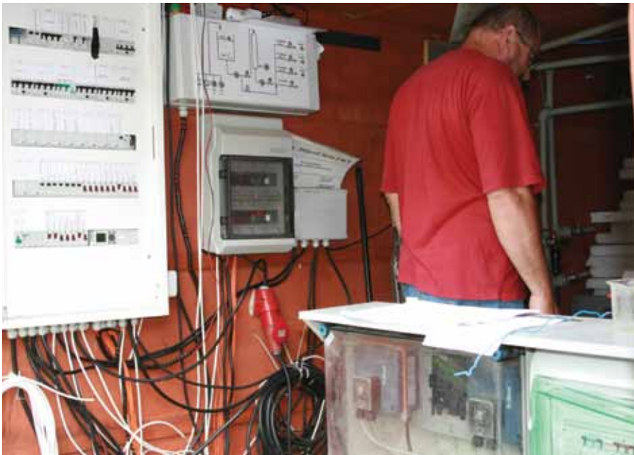
Obr. 5.1.23. Riadiaca jednotka bioreaktora (foto AWAST, spol. s r. o.).
