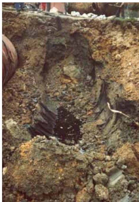
Obr. 5.1.19. Zvolen – kontaminované horninové prostredie po dostránení podzemných nádrží na PHM (foto HES-COMGEO, spol. s r. o.).
