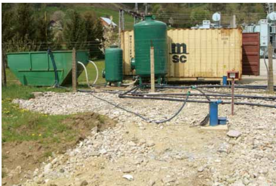
Obr. 5.1.33. Bardejov – pohľad na prevzdušňovacie vrtky a v pozadí čerpaný hydrogeologický vrt (foto GEO Slovakia, s. r. o.).
