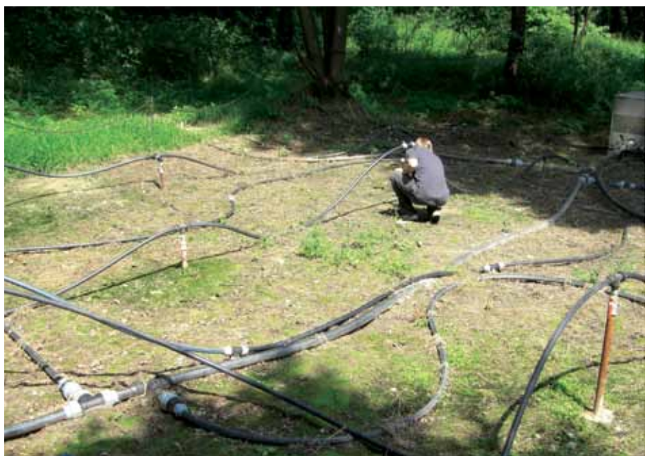
Obr. 5.2.7. Přeřov, letisko – rozmiestnenie aplikačných sond na lokalite na zabezpečenie saturácie horninového prostredia vzdušným kyslíkom a základných živín pre mikroorganizmy (foto EPS, spol. s r. o.).
