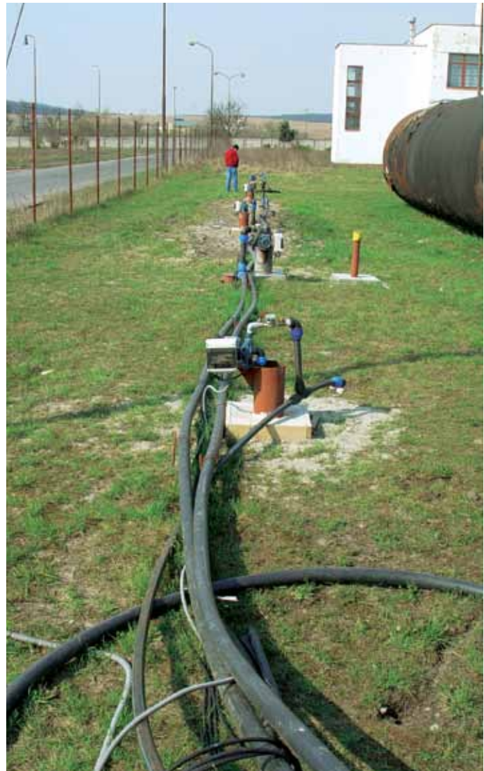
Obr. 5.1.11. Rimavská Sobota, areál bývalých ZŤS – čerpacia sústava (foto ENVIGEO, a. s.).
