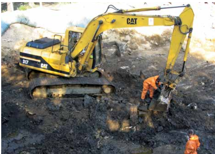
Obr. 5.2.1. Nový Rychnov, skládka priemyselného odpadu – vyťaženie kontaminovanej zeminy (archív DEKONTA, a. s.).
