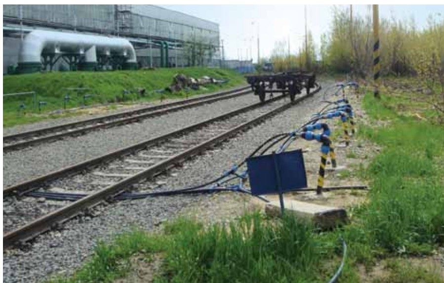
Obr. 5.1.19. Zvolen – kontaminované horninové prostredie po dostránení podzemných nádrží na PHM (foto HES-COMGEO, spol. s r. o.).
