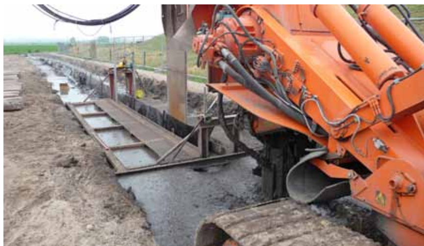
Obr. 4.1.16. Realizácia tesniacej plastovej steny Geolock do hĺbky 10 m (foto: Cofra – Chemia, s. r. o.).
