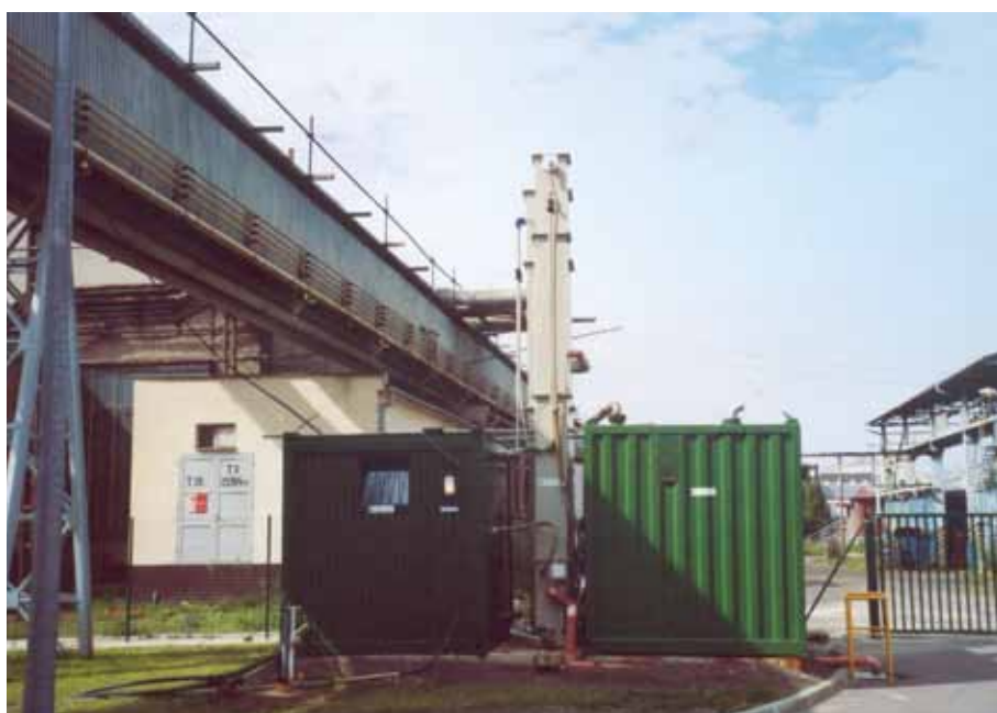
Obr. 5.1.16. Sanačná jednotka – gravitačno-sorpčný odlučovač, dve stripovacie veže, katalytický oxidizér (foto HES-COMGEO, spol. s r. o.).
