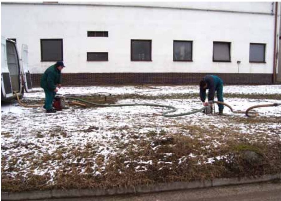
Obr. 5.2.9. Uherský Brod, areál spoločnosti Česká zbrojovka, a. s. – aplikácia srvátky do aplikačných sond (poprepávané aplikačné sondy napojené na dúchadlo, zabezpečujúce saturáciu horninového prostredia vzdušným O_2 , a slúžiace aj na aplikáciu baktérií a živín) (foto ÉPS, spol. s r. o.).
