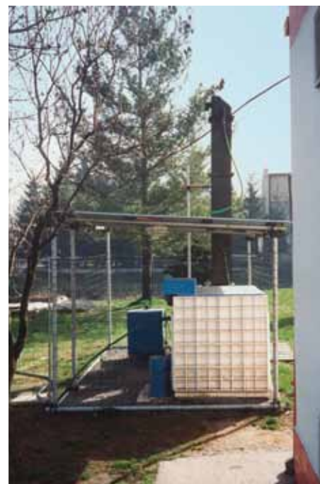
Obr. 5.1.20. Sanačná stanica (foto HES-COMGEO, spol. s r. o.).
