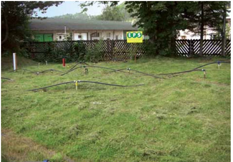
Obr. 5.1.13. Rajecké Teplice, čerpacia stanica pohonných hmôt – rozmiestnenie aplikačných sond a hydrogeologických objektov na lokalite (foto EPS biodegradácie, s. r. o.).
