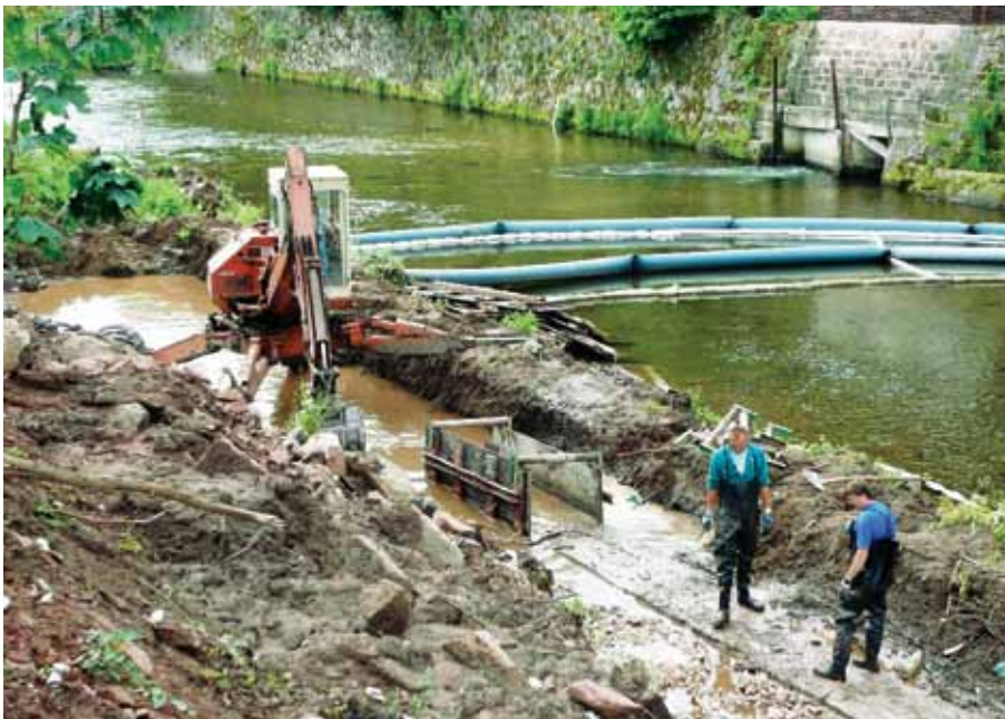
Obr. 5.2.3. Trutnov, depo Českých dráh – ochranný sanačný drén pozdĺž brehu a nornej steny na rieke Úpe (archív DEKONTA, a. s.).
