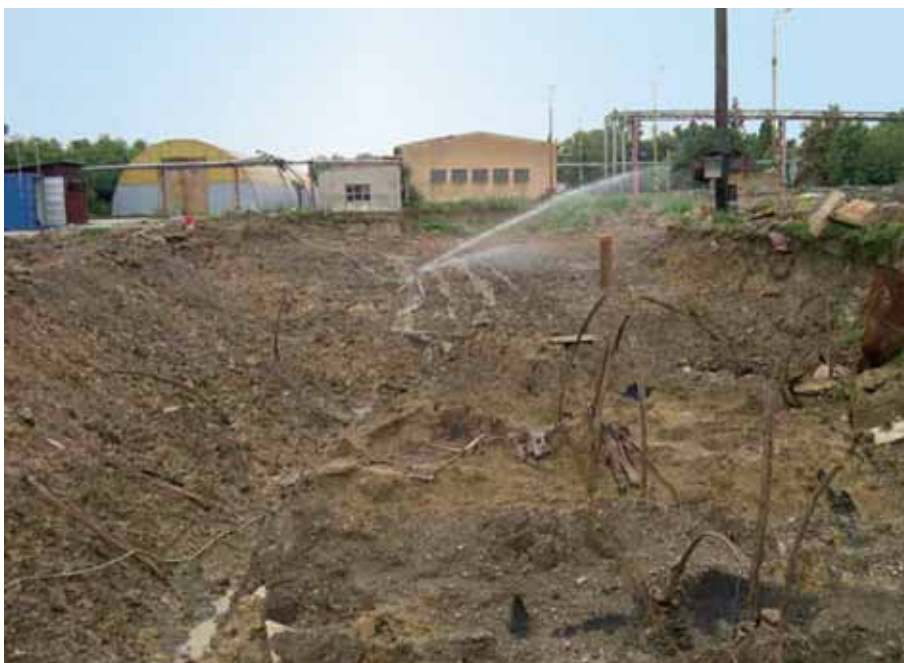
Obr. 5.1.5. Pozdišovce, bývalý distribučný sklad Slovnaftu, a. s. – aplikácia biopreparátu počas sanácie (Dekonta Slovensko, 2009).
