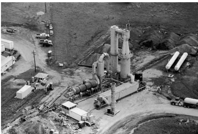
Obr. 4.1.42. Príklad mobilnej prevádzky priameho spaľovania kontaminovaných zemín ( www.tdxassociates.com ).
