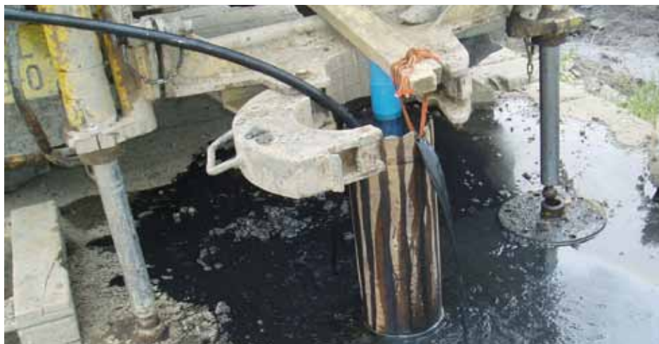
Obr. 2.4.4. Geotechnický monitoring pri sanácii lagún v areáli Chemopetrol Litvínov – vŕtanie sond na inklinometrické meranie (foto ARCADIS Geotechnika, a. s.).
