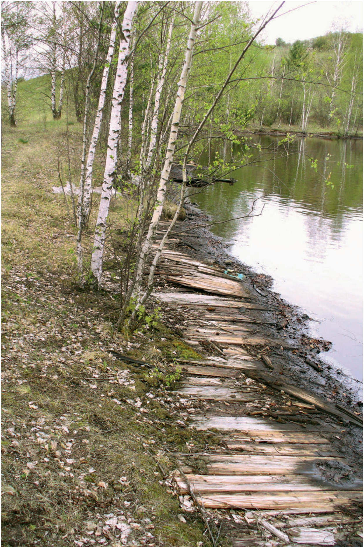
Lokalita Predajná I. – skládka gudrónov s pozostatkom sanačného zásahu – konštrukcie prekrytia environmentálnej záťaže
