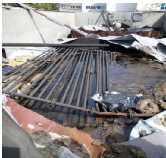
Obr. 9: Bývalé nádrže na mazut
