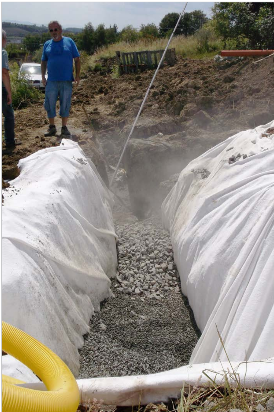
Obr. 80: Kapušany – realizácia drenážno-stabilizačného rebra (2014)
