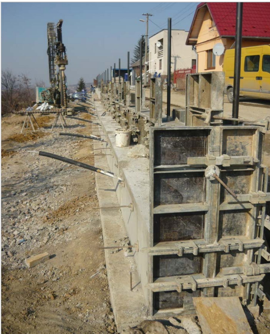
Obr. 92: Nižná Myšľa – výstavba kotveného oporného múru (2012)
