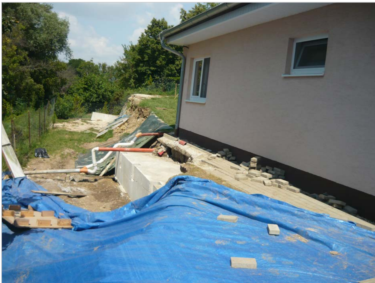
Obr. 53: Vinohrady nad Váhom – podchytené základy rodinného domu (2011)
