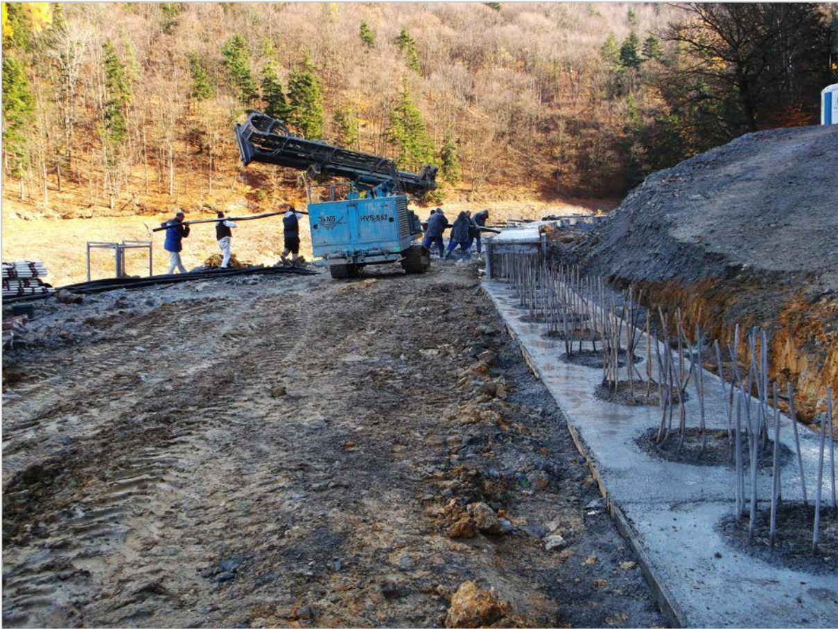
Obr. 64: Hodruša-Hámre – kotvená pilóťová stena počas výstavby (2015)
