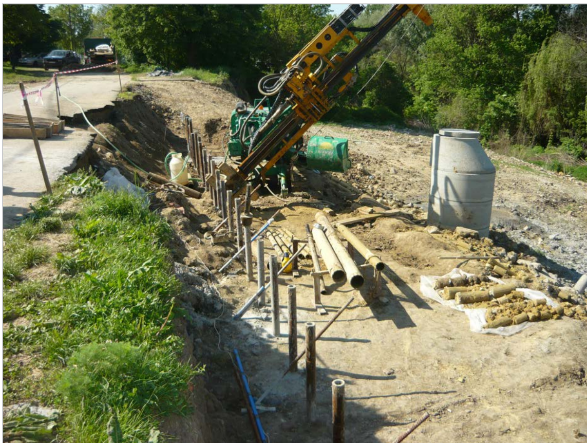
Obr. 54: Vinohrady nad Váhom – zabezpečenie komunikácie mikropilótami (2012)
