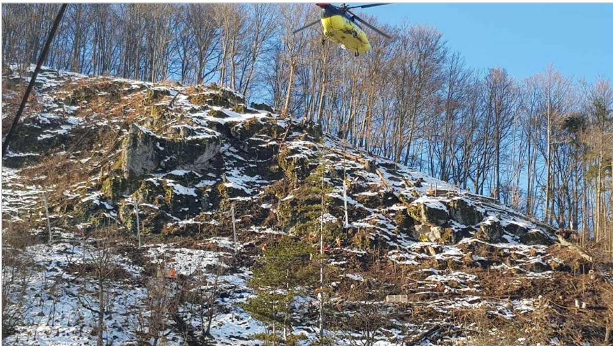
Obr. 62: Kozelník – doprava materiálu vrtuľníkom počas sanačných prác (12/2017)
