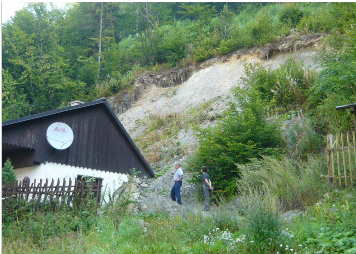
Obr. 96: Kojšov – zosuvom poškodený rodinný dom v obci (2011)
