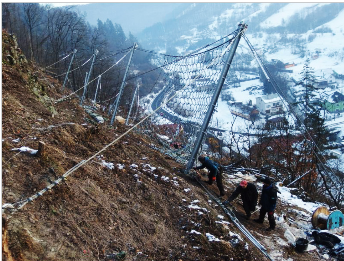
Obr. 63: Kozelník – inštalácia zachytnej dynamickej bariéry (12/2017)
