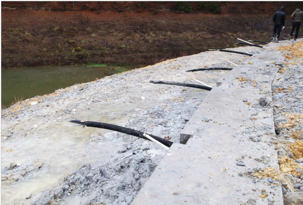
Obr. 65: Hodruša-Hámre – kotvená pilóťová stena pred napnutím kotiev (2015)
