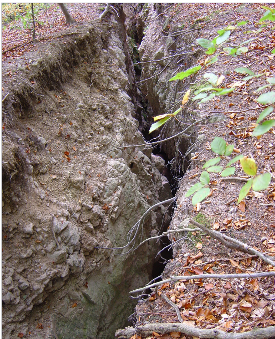
Obr. 36: Trhliny na svahoch Vtáčnika
