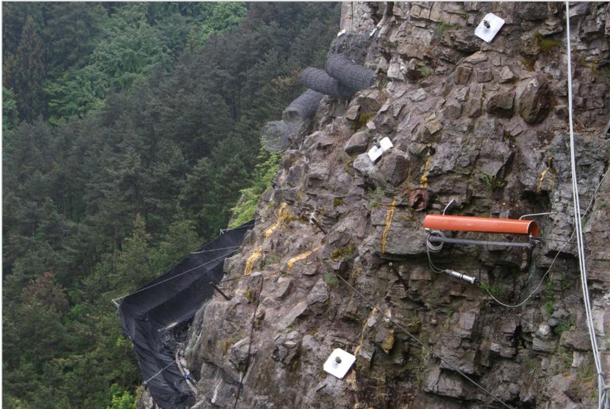
Obr. 71a, 71b: Strečno – prípravné práce na sieťovaní porušeného skalného bloku hradného brala (foto: archív MŽP SR, 2017)
