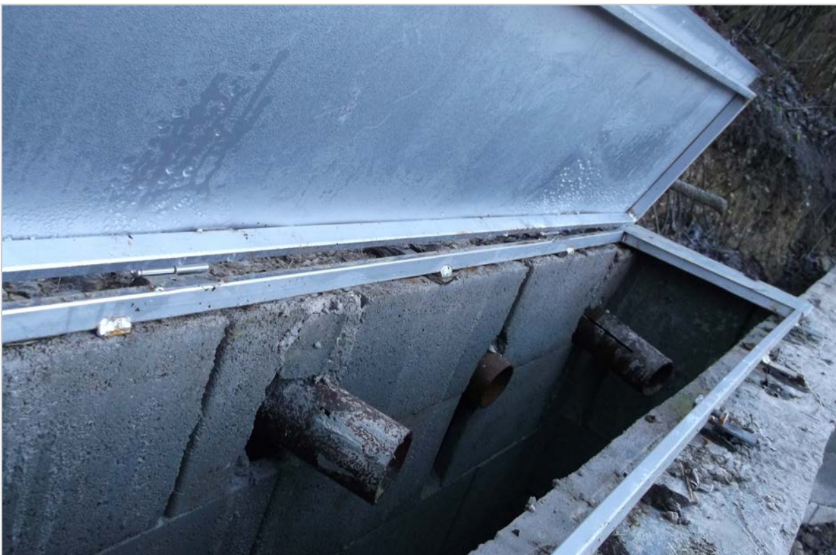
Obr. 99: Košice – Prvosienková ul. – vyústenie subhorizontálnych vrtov (detail, 2014)
