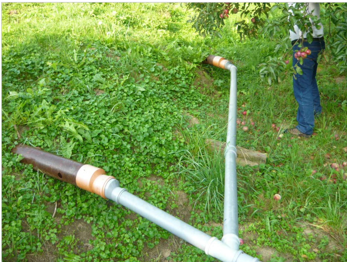
Obr. 51: Šenkvice – odvedenie vôd zo subhorizontálnych vrtov (2011)
