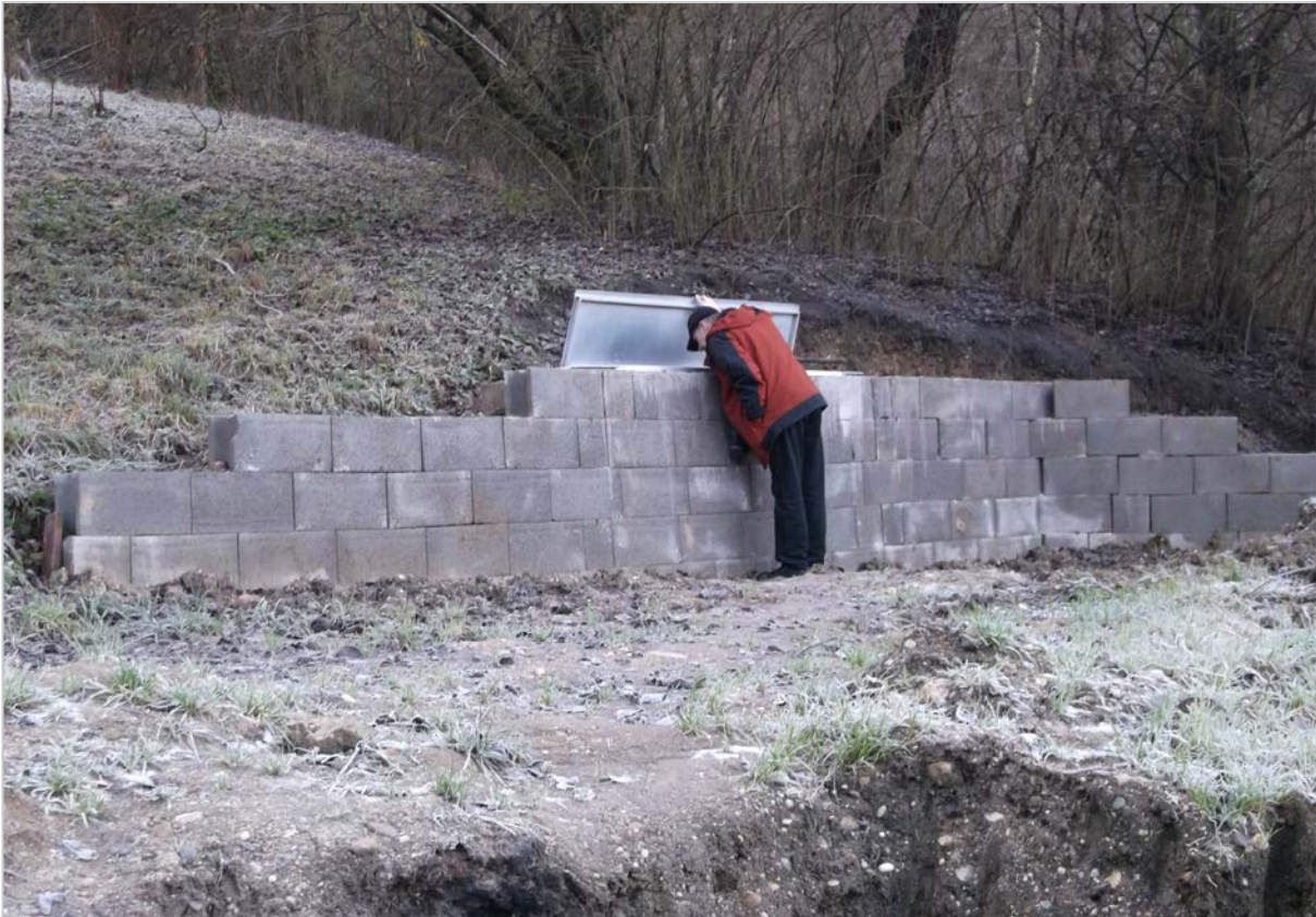
Obr. 98: Košice – Prvosienková ul. – zrealizované subhorizontálne odvodňovacie vrty (2014)
