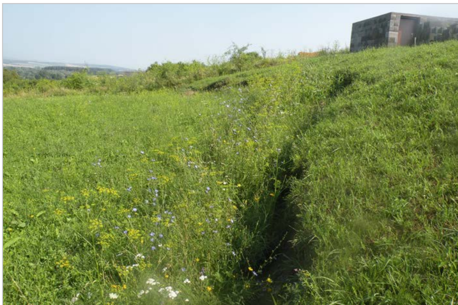
Obr. 35: Trhliny v zosuve v Nižnej Myšli
