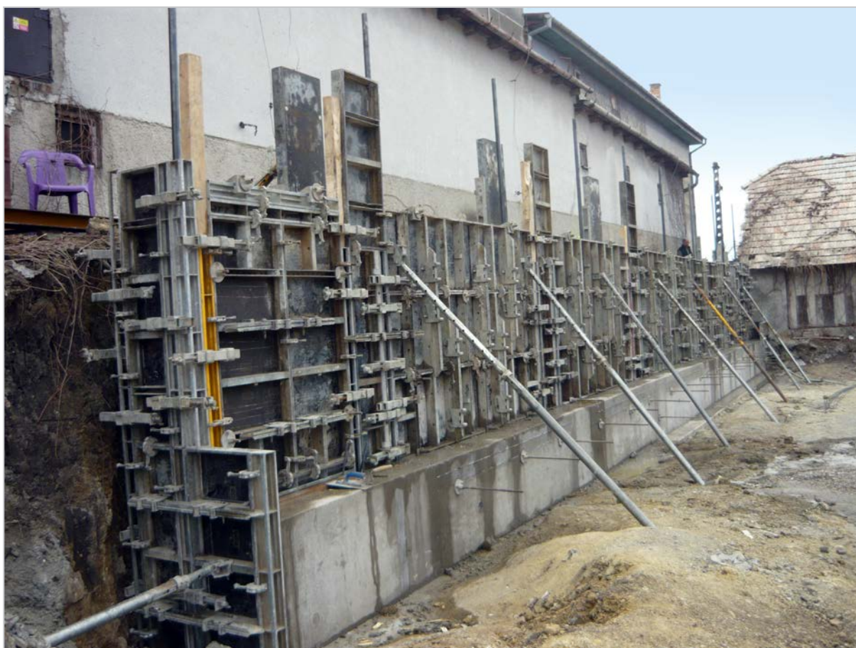
Obr. 90: Nižná Myšľa – výstavba oporného múru (2012)
