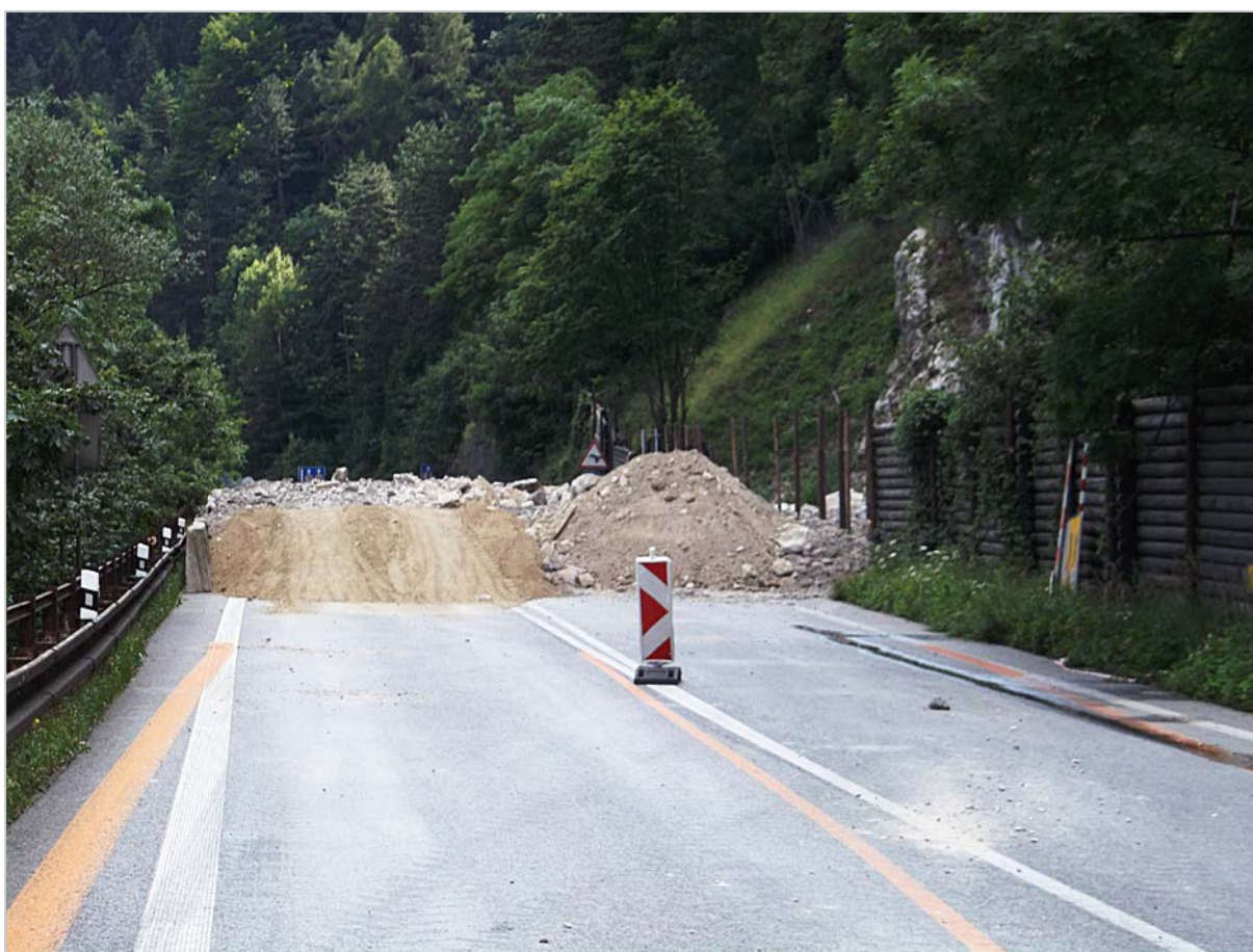
Obr. 74: Strečno – príprava ochranného „vankúša“ na ceste pred riadeným odstránením skalného bloku (2017)
