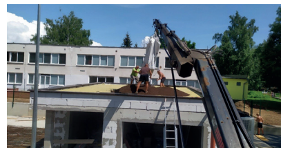
Zelená vegetačná strecha pri novej ľadovej ploche
