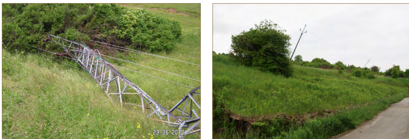
Obr. 9.9: Deštrukcia stožiaru VVN v obci Dubovica (2010) a naklonené stĺpy elektrického vedenia v Nižnej Myšli (foto: P. Liščák, V. Jánová)
