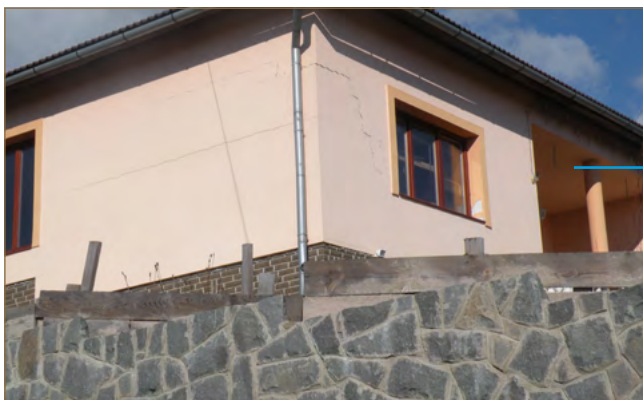
Obr. 8.23: Vľavo zosuvom poškodený rodinný dom (foto: V. Jánová), vpravo postupná asanácia toho istého objektu (foto: P. Gombos)
