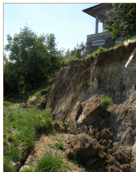
Obr. 9.2: Zvlnený a potrháný povrch zosuvného územia v Liptovskej Štiavničke a v Nižnej Myšli (foto: V. Jánová)
