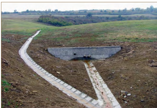
Obr. 11.7: Obvodová priekopa a rigol na zosuve na diaľnici D1 pri Chmiňanoch (foto: M. Kopecký)
