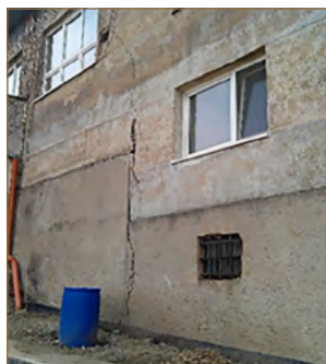
Obr. 8.57: Poškodený obecný úrad a stav po vybudovaní pilótovej podzemnej steny (foto: V. Jánová)
