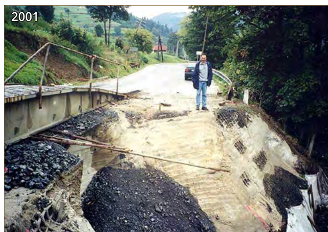
Obr. 3.18: Plynúce zosuvy v roku 1997 a 2001 v Ľubovnianskej vrchovine po intenzívnych zrážkach (foto: M. Kopecký, P. Abrahám)
