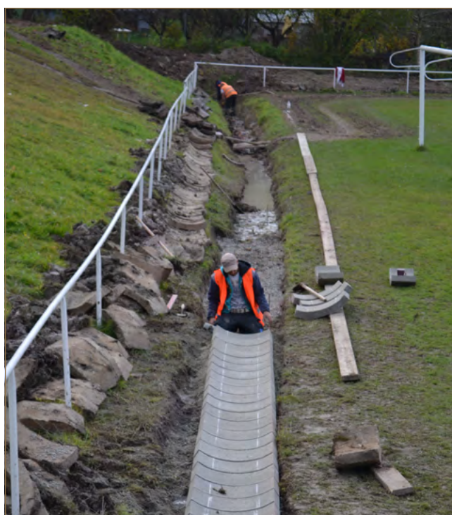
Obr. 11.11: Odvodňovacie rigoly na zosuve v Prievidzi (foto: K. Házyová)
