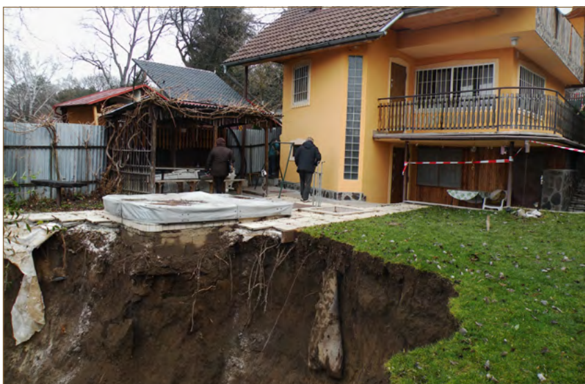
Obr. 9.2: Zvlnený a potrháný povrch zosuvného územia v Liptovskej Štiavničke a v Nižnej Myšli (foto: V. Jánová)
