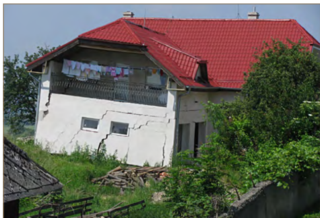
Obr. 8.3: Zosuvom porušený rodinný dom v Nižnej Myšli (foto: V. Jánová)
