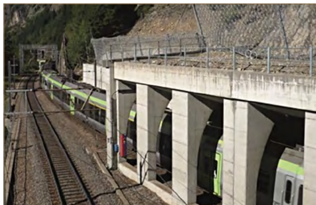
Obr. 11.74: Príklad ochrannej galérie zo Švajčiarska (zdroj: www.geobrugg.com )
