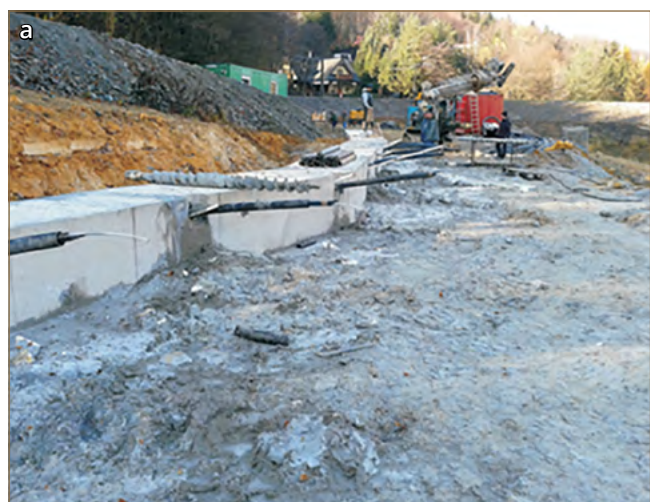
Obr. 11.45: Osadené lanové horninové kotvy (a) a pohľad na dokončenú kotvenú pilótovú stenu s napnutými horninovými kotvami (b) v lokalite Hodruša-Hámre (Gomolčák a kol., 2015)
