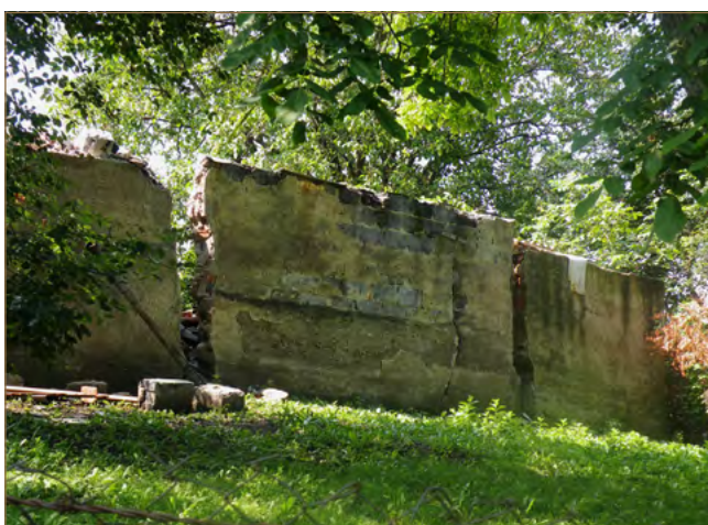
Obr. 8.50: Trhliny v múroch (foto: V. Jánová)
