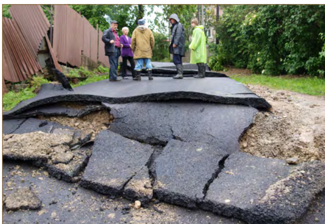
Obr. 8.49: Zosuvom poškodené miestne komunikácie (foto: Ľ. Petro)
