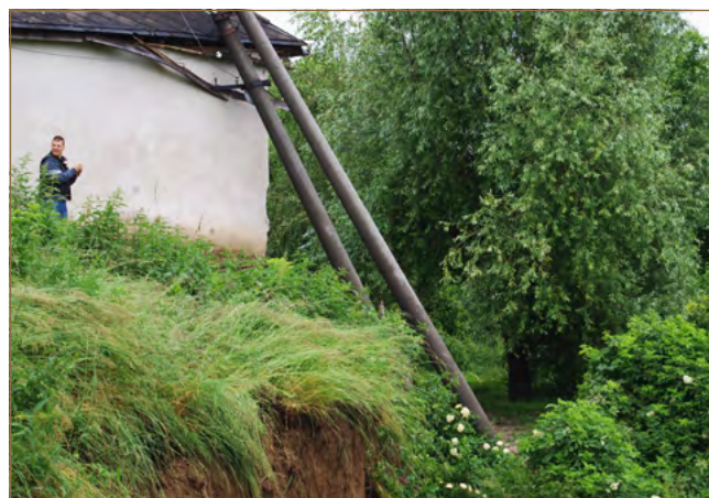
Obr. 8.51: Rozbahnené zosuvné masy v dôsledku poškodených potrubí a vyvrátené elektrické stĺpy sú dôkazom poškodenia inžinierskych sietí (foto: Ľ. Petro)
