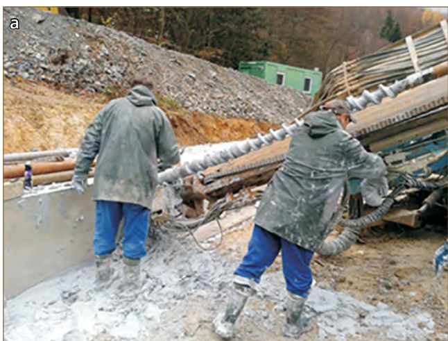
Obr. 11.43: Vŕtanie horninových kotiev (a) a príprava lanovej horninovej kotvy (b) (Gomolčák a kol., 2015)
