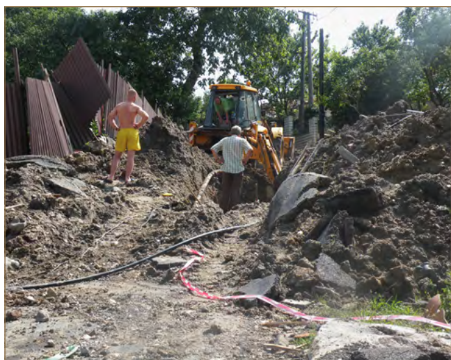
Obr. 8.56: Budovanie podpovrchového odvodnenia a vybudované subhorizontálne odvodňovacie vrty (foto: V. Jánová, L. Petro)
