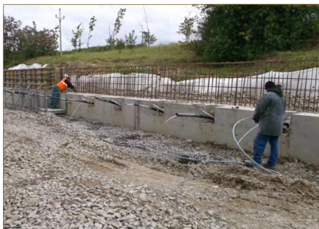
Obr. 11.32: Výstavba kotveného oporného múra v čele zosuvu v Nižnej Myšli nad základnou školou (foto: V. Jánová)
