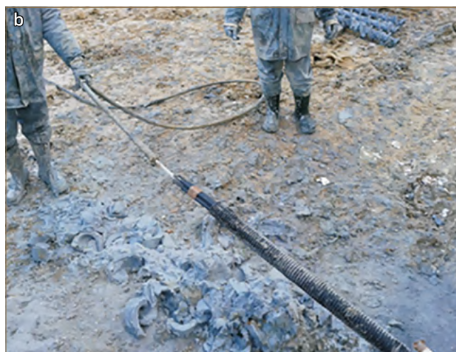
Obr. 11.44: Osadenie lanovej horninovej kotvy (a) a zálievka vnútra kotvy (b) (Gomolčák a kol., 2015)
