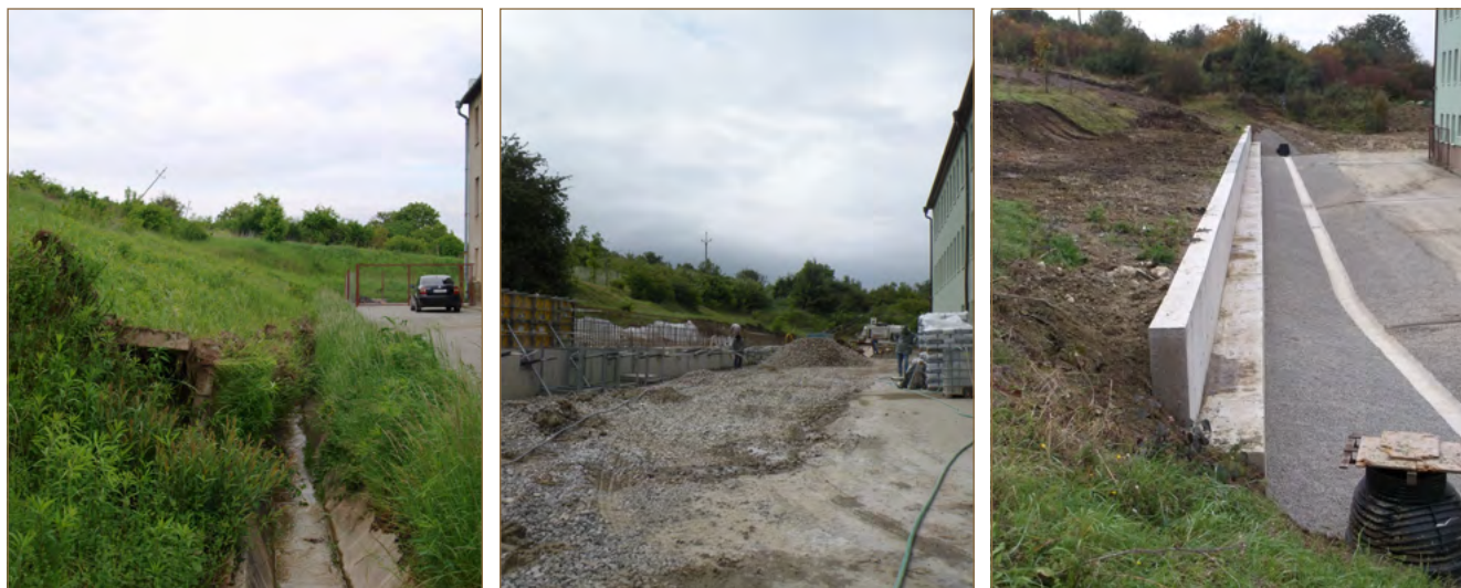
Obr. 8.61: Čelo zosuvu za základnou školou, v strede budovanie kotvenej pilótovej steny, vpravo jej výsledný vzhľad (foto: Ľ. Petro, V. Jánová, K. Házyová)
