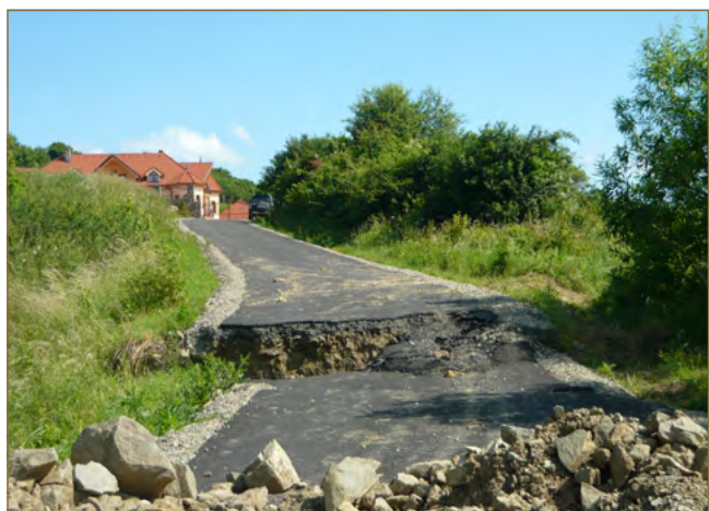
Obr. 8.25: Porušenie násypu a vozovky prístupovej cesty zosuvom v Kapušanoch (foto: V. Jánová)
