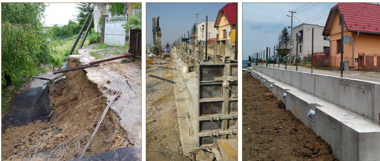
Obr. 8.54: Pohľad na odľučnú hranu zosuvu na ulici Malá Nemecká a na kotvenú železobetónovú stenu počas výstavby a pred ukončením sanácie (foto: Ľ. Petro, V. Jánová, K. Házyová)
