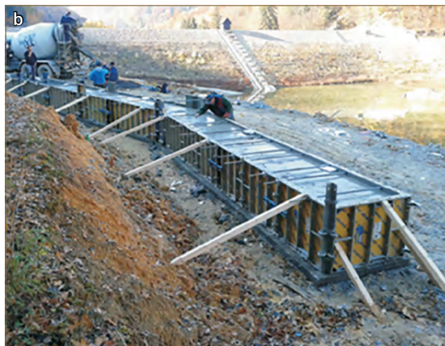
Obr. 11.42: Zriadenie armatúry kotevného mostíka a osadenie prechodiek kotiev (a) a betonáž kotevného mostíka (b) (Gomolčák a kol., 2015)
