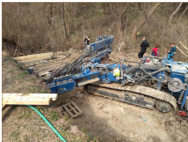
Obr. 11.18: Vrtanie subhorizontálneho odvodňovacieho vrtu na zosuve v Kapušanoch a vejára odvodňovacích vrtov na zosuve vo Varhaňovciach (foto: K. Házyová)
