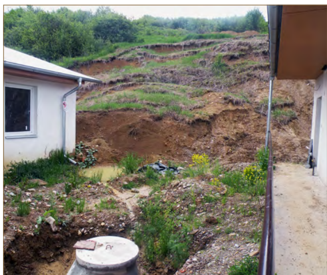
Obr. 3.10: Podrezanie svahu v obci Chmiňany pri výstavbe sociálnych bytov (foto: V. Jánová)
