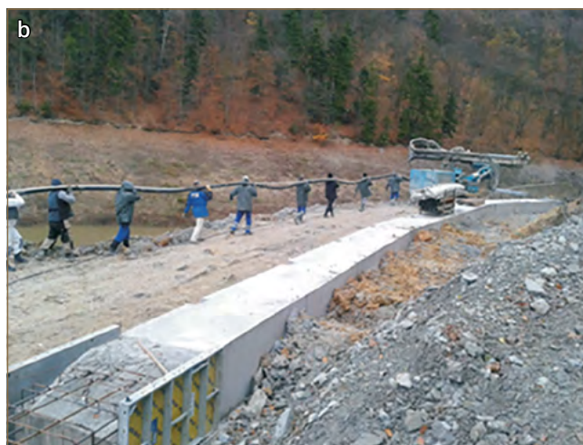
Obr. 11.43: Vŕtanie horninových kotiev (a) a príprava lanovej horninovej kotvy (b) (Gomolčák a kol., 2015)
