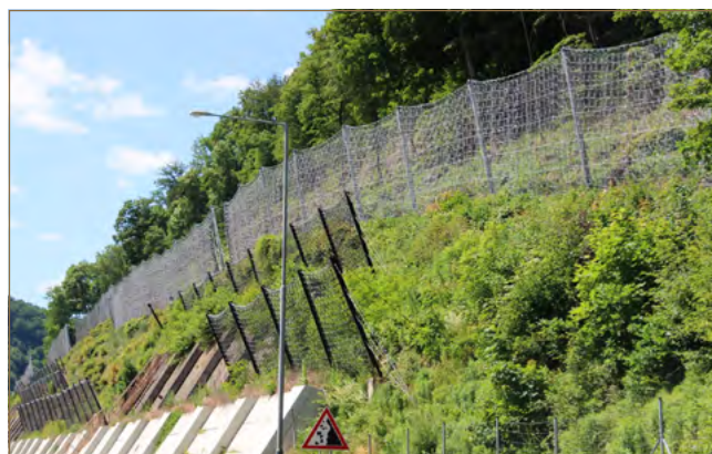
Obr. 11.65: Kombinácia dynamických bariér s obkladovými múrmi na ceste R2 v úseku Budča – Zvolen (foto: B. Prelovský)
