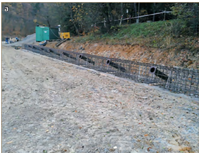
Obr. 11.42: Zriadenie armatúry kotevného mostíka a osadenie prechodiek kotiev (a) a betonáž kotevného mostíka (b) (Gomolčák a kol., 2015)
