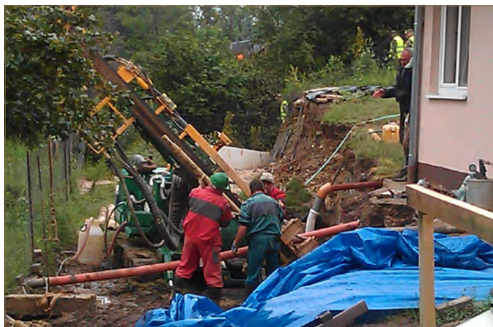
Obr. 5.20: Odlučná hrana zosuvu vo Vinohradoch nad Váhom (vľavo) a budovanie mikropilotovej steny na záchranu rodinného domu (vpravo) (foto: V. Jánová)
