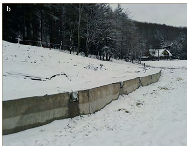
Obr. 11.45: Osadené lanové horninové kotvy (a) a pohľad na dokončenú kotvenú pilótovú stenu s napnutými horninovými kotvami (b) v lokalite Hodruša-Hámre (Gomolčák a kol., 2015)
