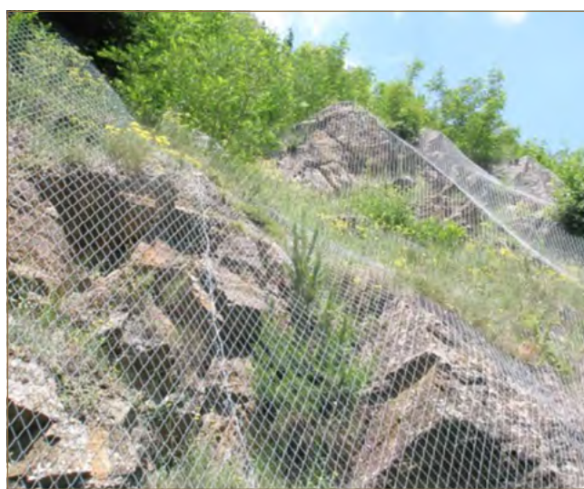
Obr. 11.66: Ukážka závojového systému z ocelových sietí (zdroj: www.geobrugg.com )
