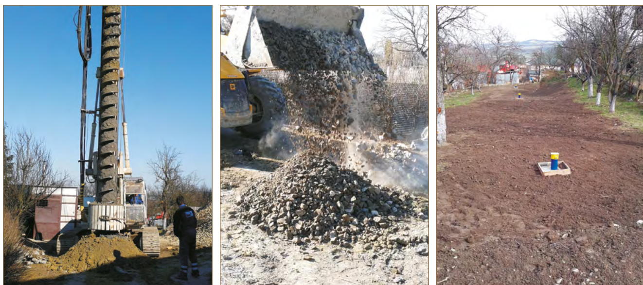
Obr. 8.62: Drenážna štrková stena – vľavo vŕtanie štrkových pilót, v strede zásyp štrkodrvou, vpravo upravený povrch terénu so zabudovaným piezometrom (Laurenčík a kol., 2015)
