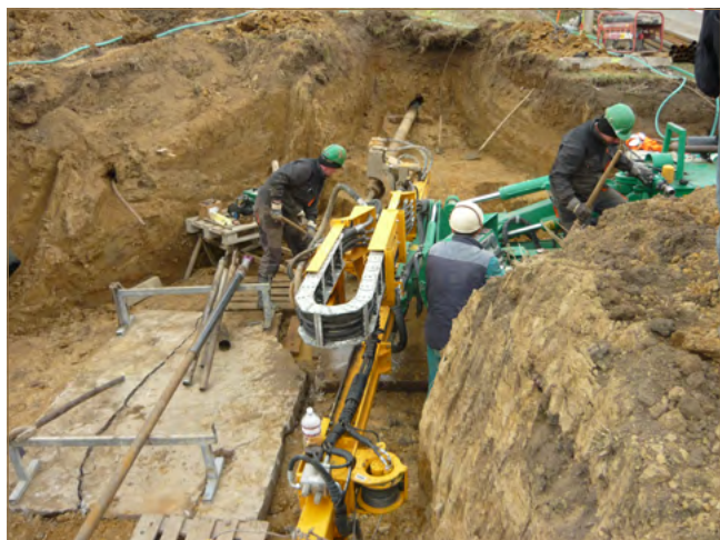
Obr. 11.18: Vrtanie subhorizontálneho odvodňovacieho vrtu na zosuve v Kapušanoch a vejára odvodňovacích vrtov na zosuve vo Varhaňovciach (foto: K. Házyová)
