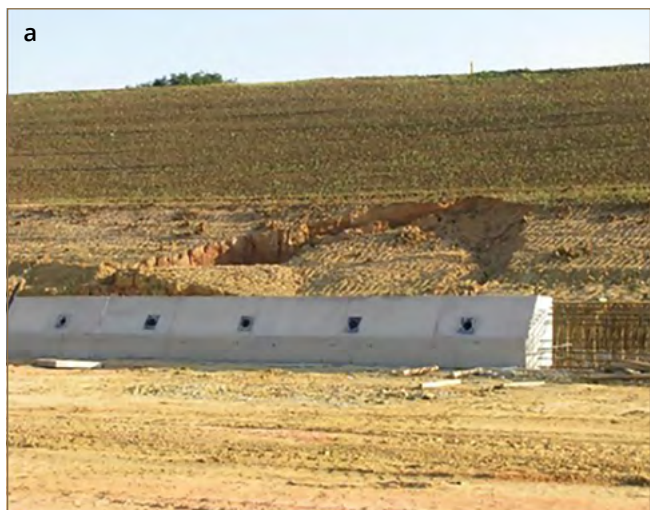
Obr. 11.39: Sanácia zárezu v zosuve na trase R4 Košice – Milhošť pilótovou stenou: a) aktivizácia zosuvu pred dokončením pilótovej steny, b) dokončená pilótová stena (foto: M. Kopecký)
