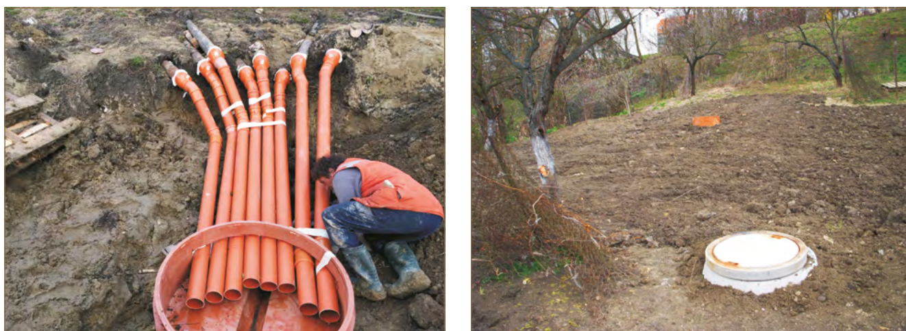
Obr. 8.63: Subhorizontálne odvodňovacie vrtý – vľavo zaústenie do zbernej šachty, vpravo povrchová úprava terénu v mieste zbernej šachty (Laurenčík a kol., 2015)
