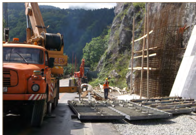
Obr. 5.23: Sanačné práce na skalnom brale pod hradom Strečno (foto: K. Házyová)
