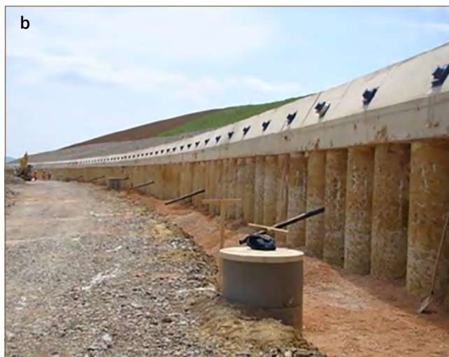
Obr. 11.39: Sanácia zárezu v zosuve na trase R4 Košice – Milhošť pilótovou stenou: a) aktivizácia zosuvu pred dokončením pilótovej steny, b) dokončená pilótová stena (foto: M. Kopecký)
