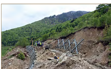
Obr. 11.35: Konštrukcia ErdoX Terra (vľavo) a spôsob jej zabudovania (vpravo) (Prelovský, Sňahničan, 2019)
