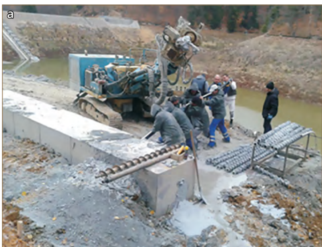
Obr. 11.44: Osadenie lanovej horninovej kotvy (a) a zálievka vnútra kotvy (b) (Gomolčák a kol., 2015)
