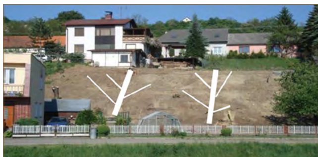
Obr. 8.20: Schéma umiestnenia stabilizačno-drenážnych rebier v lokalite Krupina (Liščák a kol., 2011)
