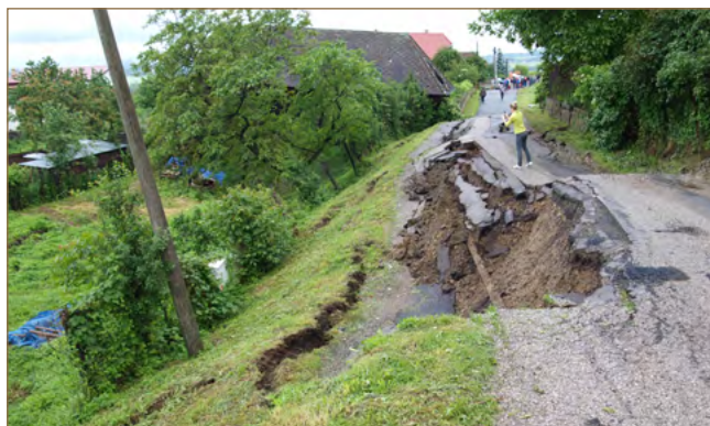
Obr. 8.58: Poškodená miestna komunikácia a jej stav po oprave (foto: Ľ. Petro, V. Jánová)
