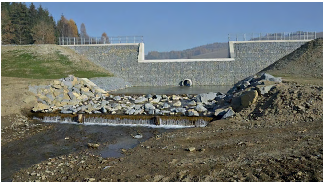
Príklad preventívneho opatrenia na ochranu pred povodňami – suchý polder na Lubickom potoku (Zdroj: spis.korzar.sme.sk/c/20285532/protipovodnove-opatrenia-na-spisi-sa-osvedcili.html)
