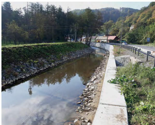
Upravené koryto vodného toku Neresnica, realizácia z roku 2019 (Foto: M. Kamenský)
